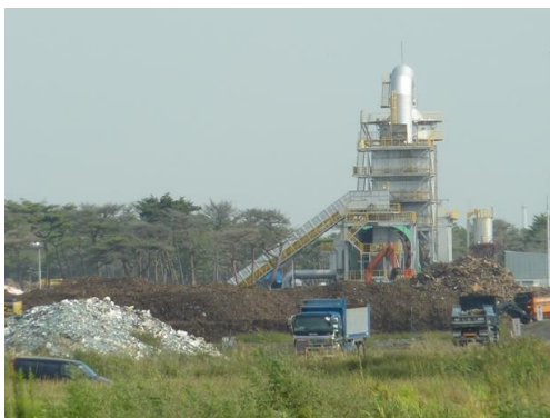
仙台市荒浜処理場
